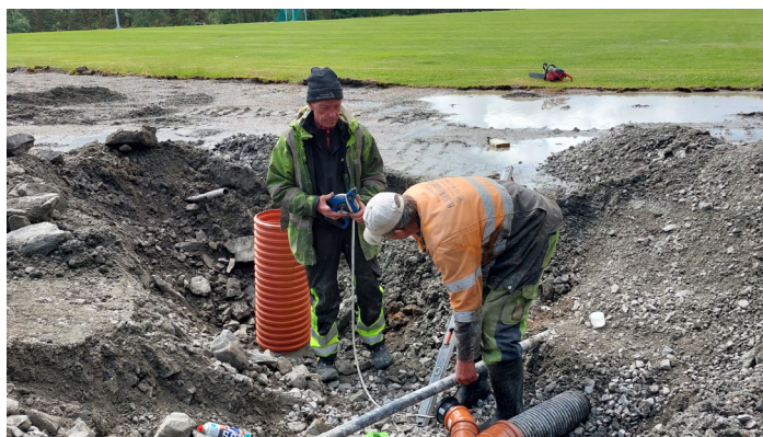
Det krevst mykje grunnarbeid før toppdekket kan leggjast
